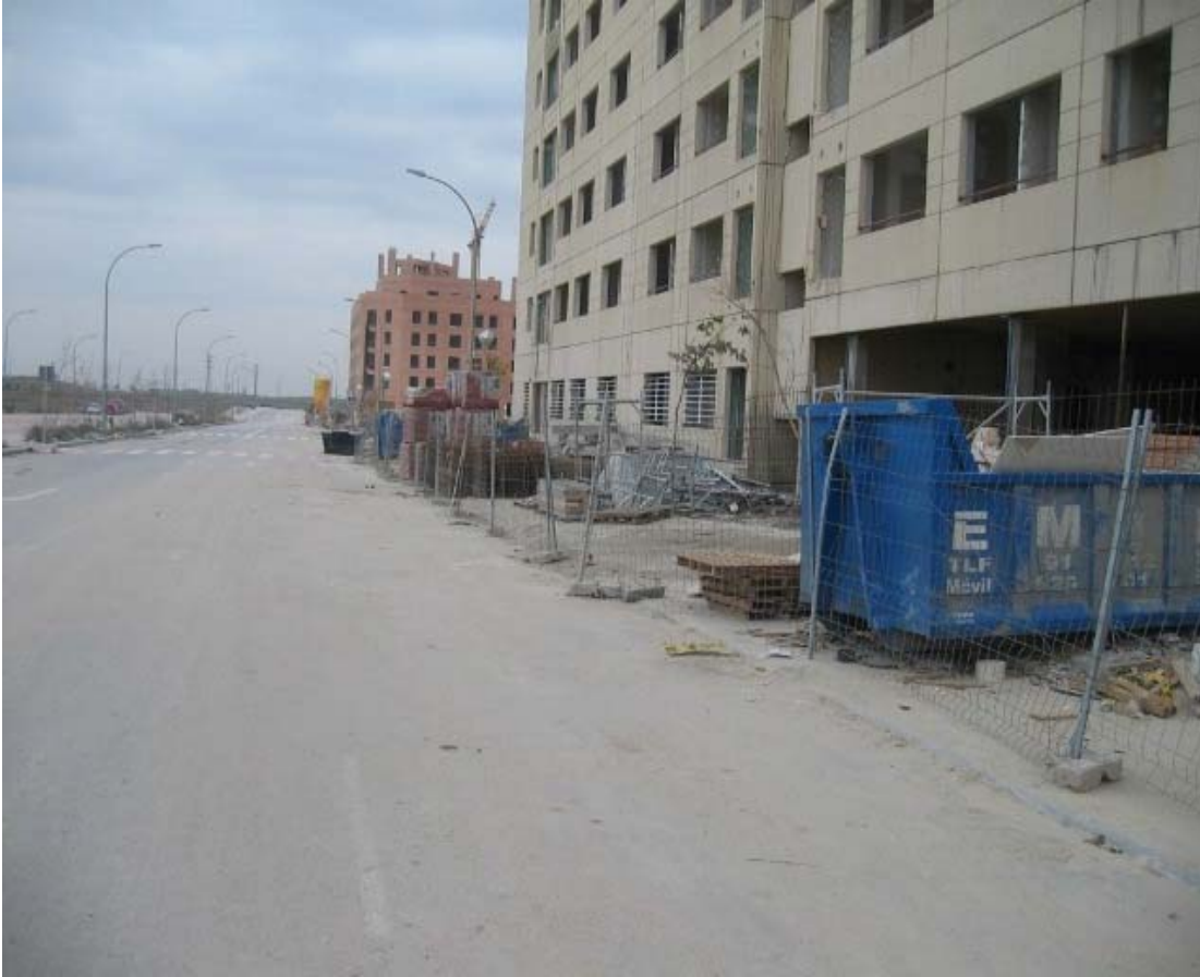
Vallado de entrada general fachada sur.
