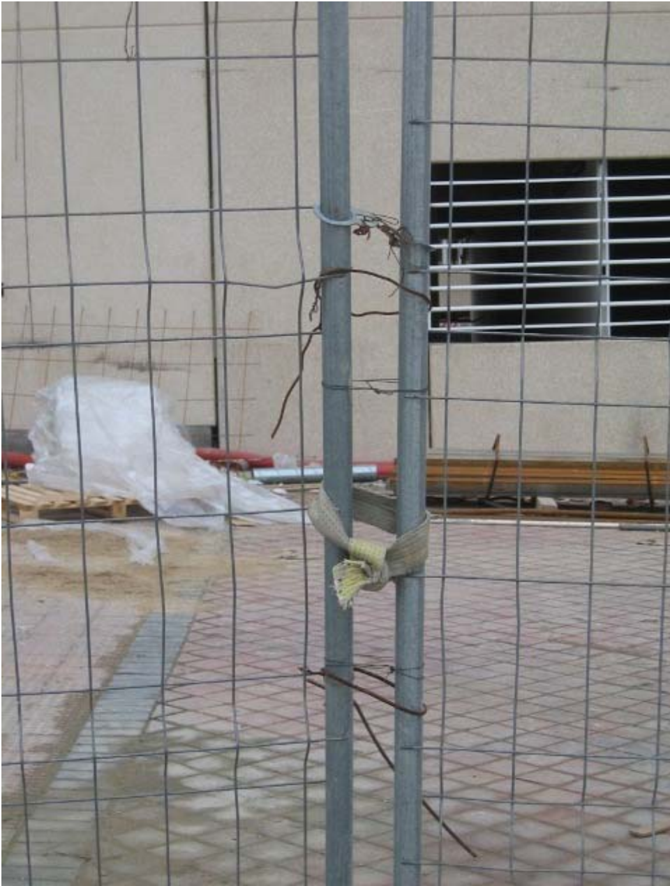
Atado con alambre entre vallas.
