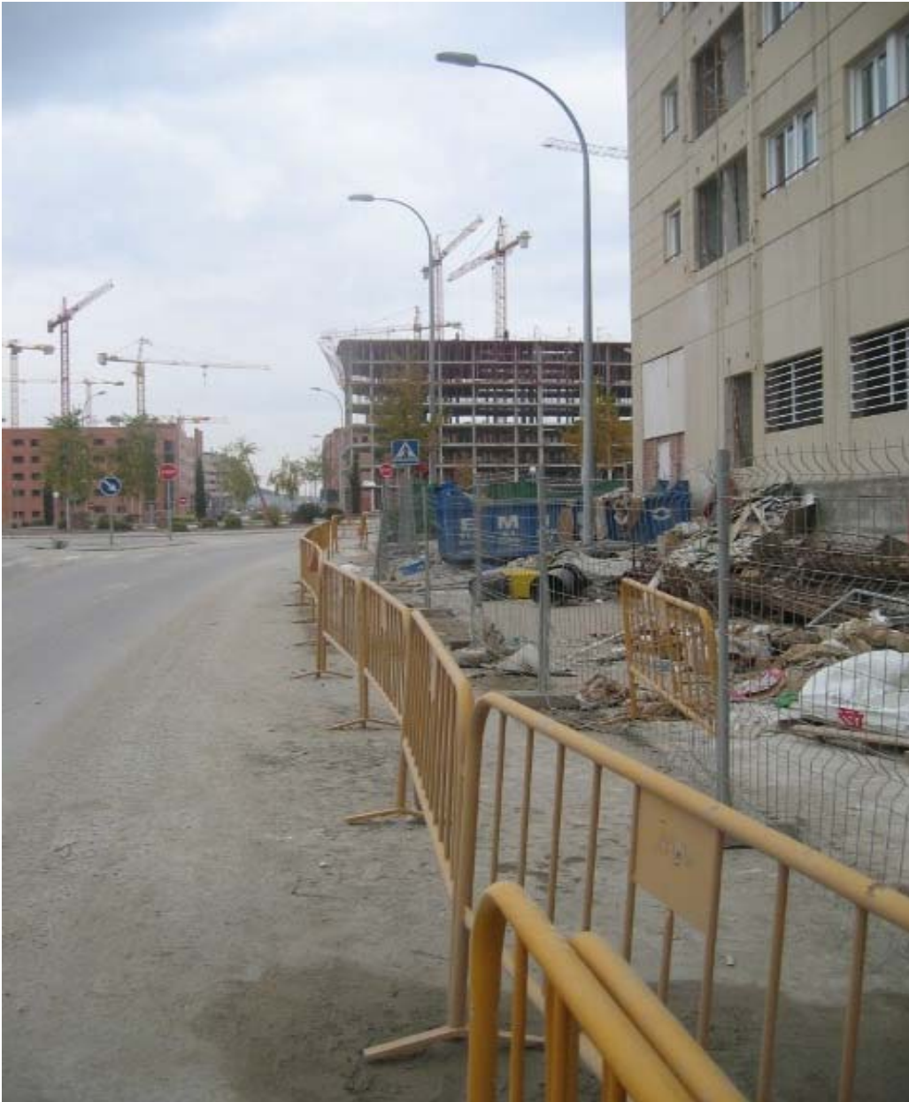
Paso peatonal fachada norte.
